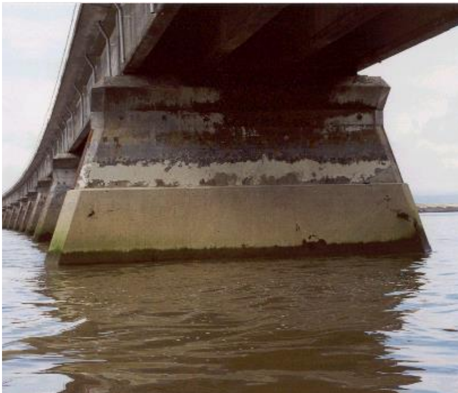
Mynd 3. Borgarfjarðarbrú stöpull 4. Kápusteypa frá 1998. Myndin er tekin árið 2000.
