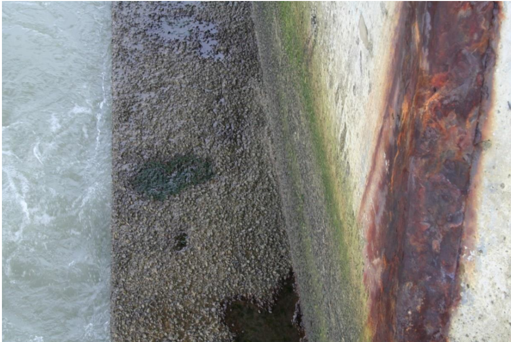
Mynd 8. Óseyrarbrú, stöpull 4, yfirborð sökkuls. Neðri fjörumörk.
