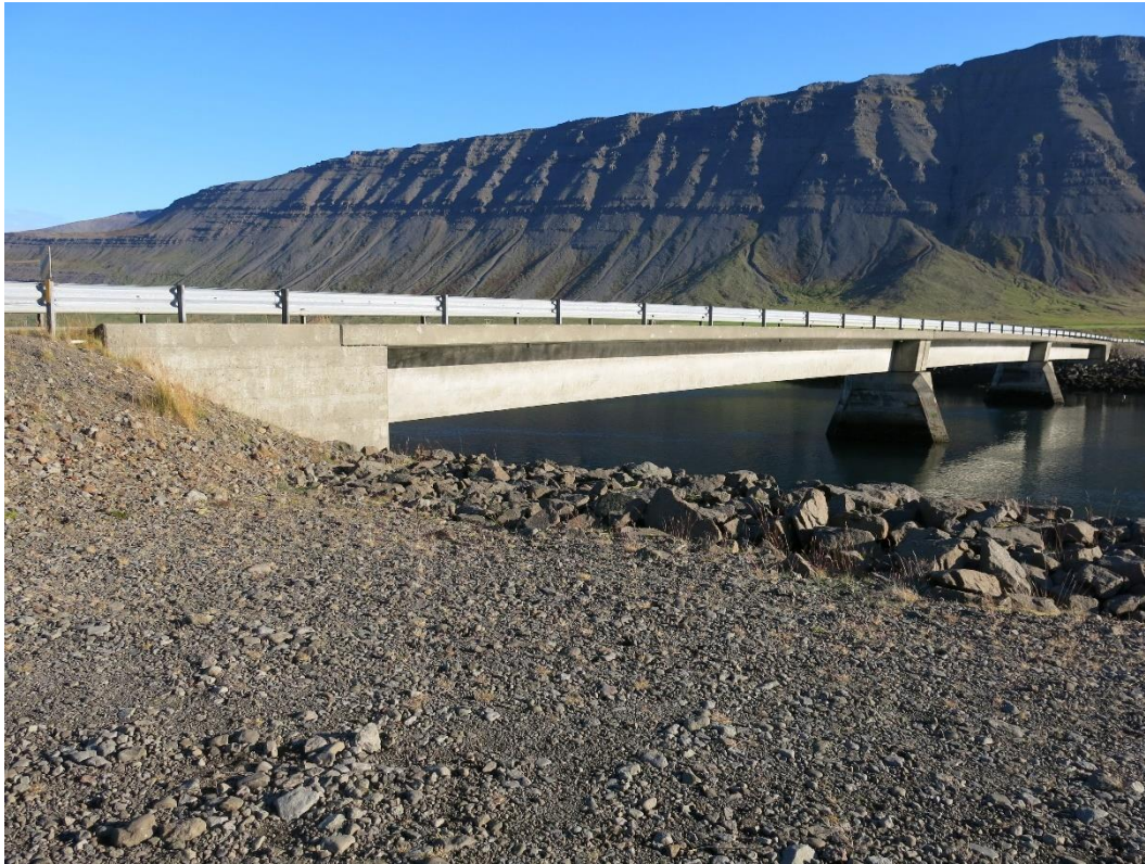
Mynd 13. Dýrafjarðarbrú. Brúin var steipt árið 1990.
