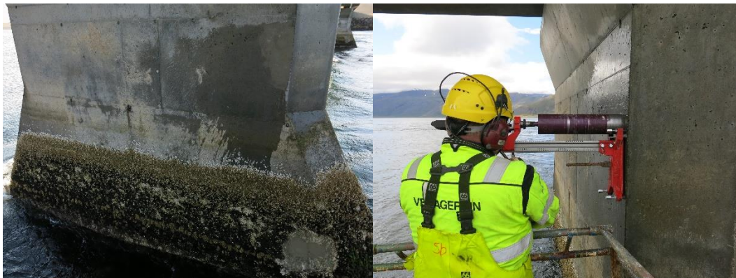
Mynd 16. Kolgrafafjarðarbrú. Engar skemmdir voru sjáanlega í yfirborði steypunnar, t.v. Kjarni boraður úr efri fjörumörkum t.h.
