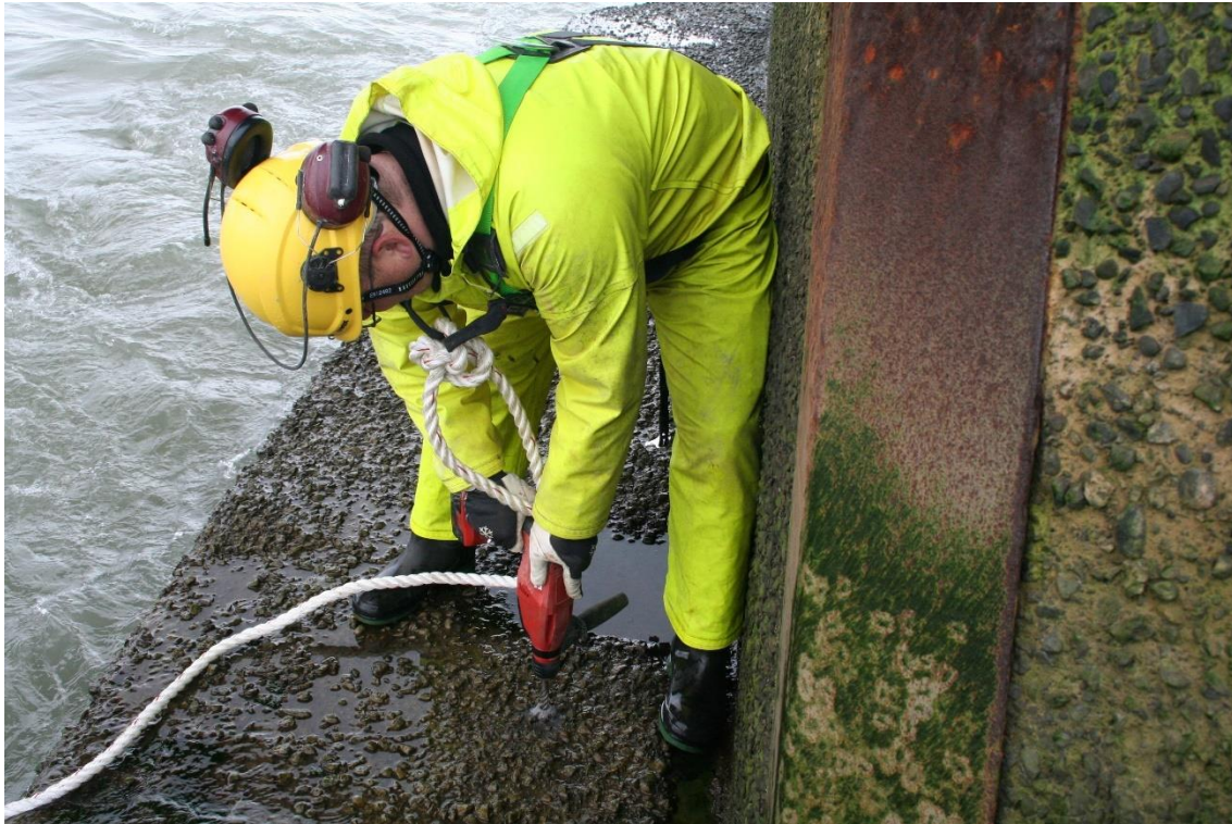
Mynd 12. Óseyrarbrú, stöpull 4. Kjarni boraður úr stöpsteypu við neðri fjörumörk.
