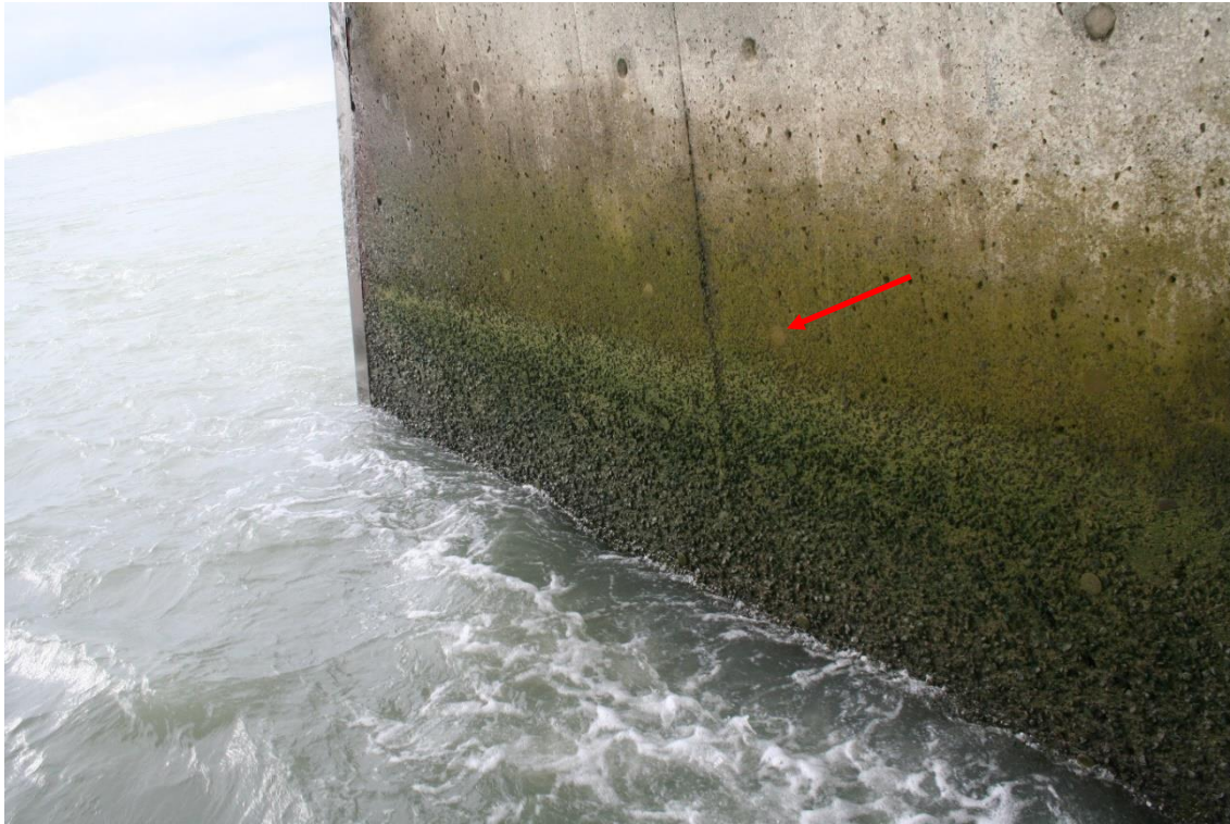
Mynd 6. Óseyrarbrú, stöpull 5. Flögnun í steypunni við meðal fjörumörk. Rauða örin bendir á kónagat.
