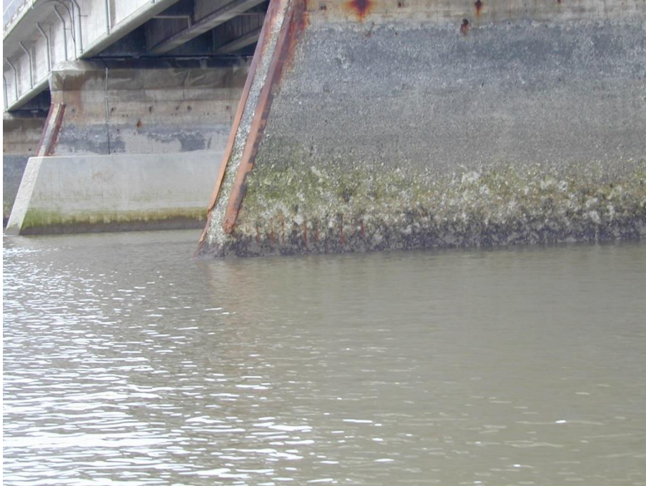
Mynd 2. Brynvarnarjárn á stöpli í Borgarfjarðarbrú í neðstu fjörumörkum (stór streymisfjara). Kápusteypa í stöpli 9 í bakgrunni. Myndin er tekin árið 2000.
