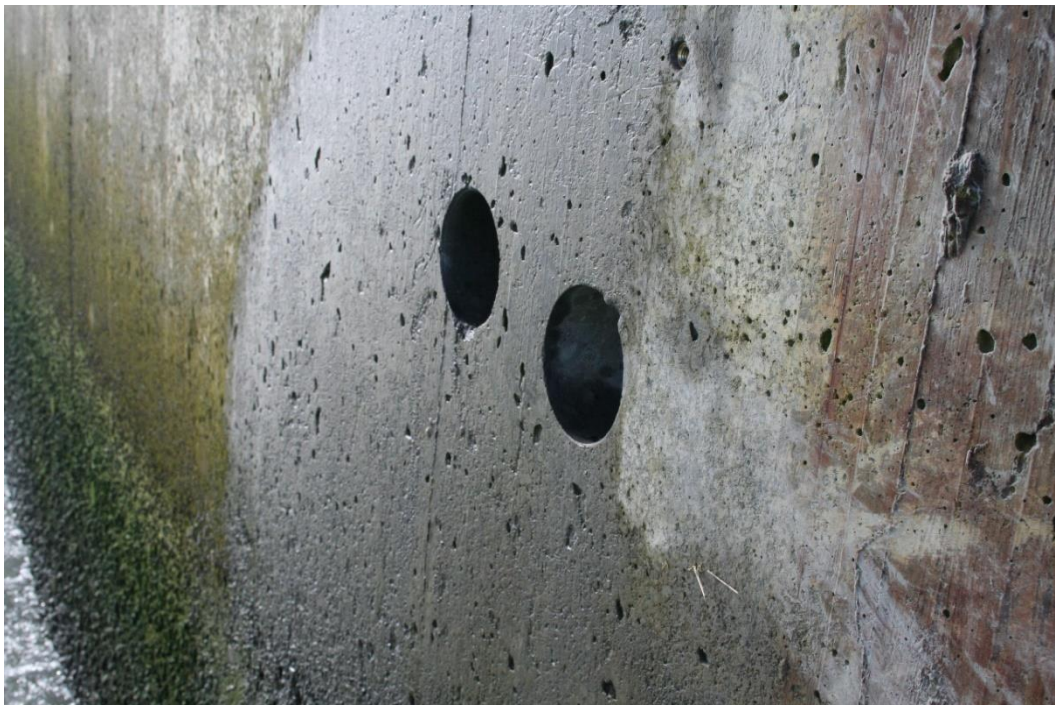
Mynd 9. Óseyrarbrú, stöpull 5. Sýnatökustaðir í efri fjörumörkum.
